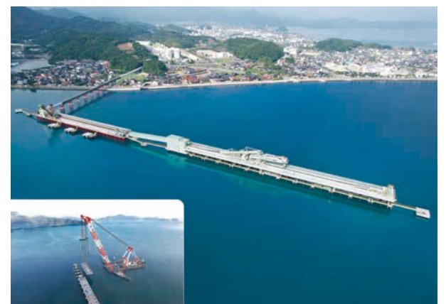
秋芳館山栈橋延伸工事【山口県】
