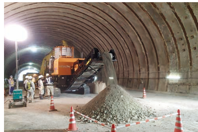
重金属等の不溶化工法実施作業
