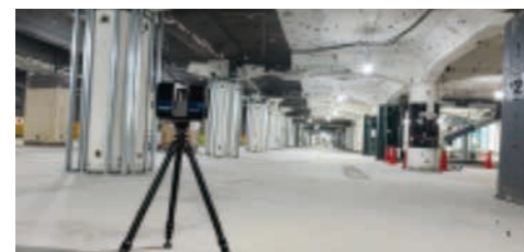
レーザースキャナによる測量
