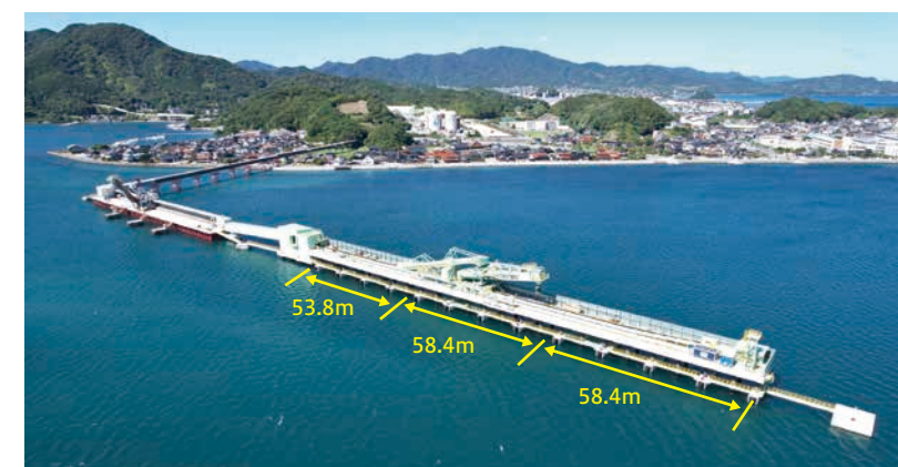
秋芳鉱山栈橋延伸工事
