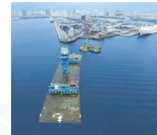
東京港 海の森トンネル
