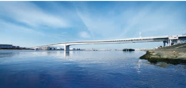
多摩川スカイブリッジ
