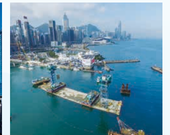
MTR 沙田至中環線1121工区海底トンネル (香港)
