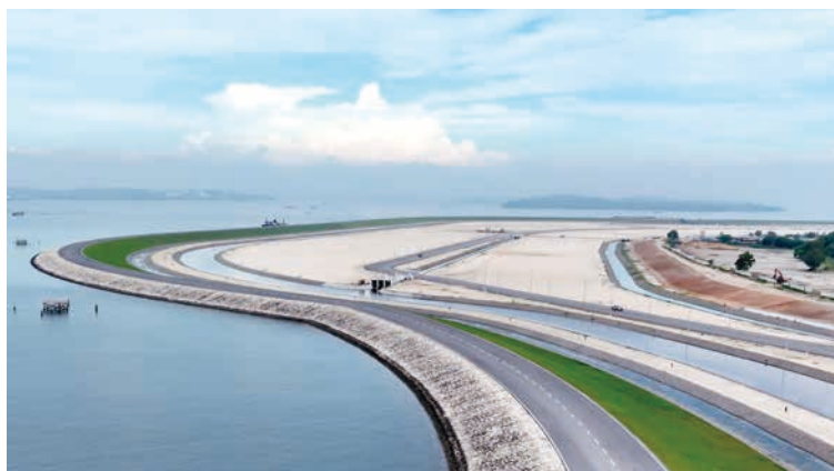
デコン島A・C地区干拓地造成工事[シンガポール] (提供：HDB)
