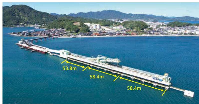
秋芳鉱山栈橋延伸工事
