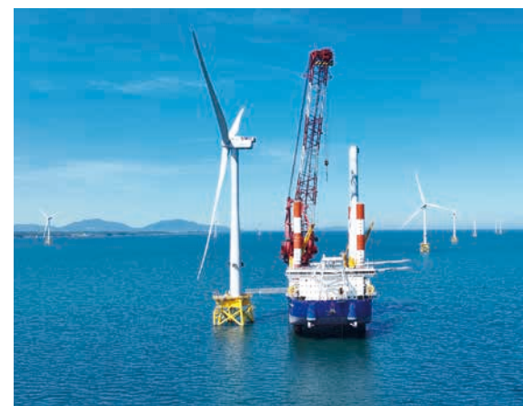
風車の据付状況(CP-16001)
