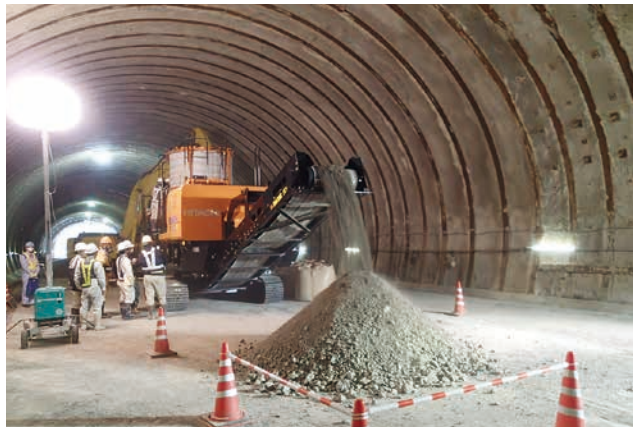
重金属等の不溶化工法実施作業
