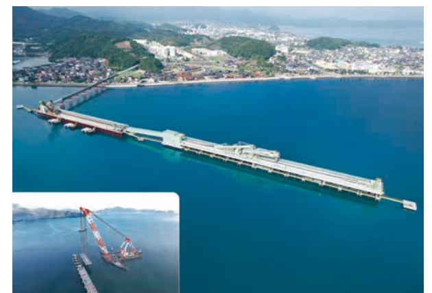
秋芳館山栈橋延伸工事[山口県]
