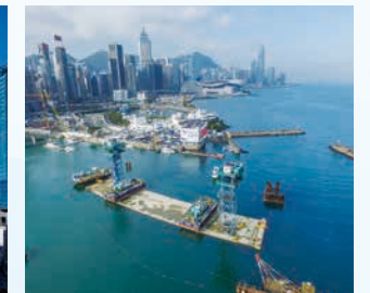
MTR 沙田至中環線1121工区海底トンネル (香港)
