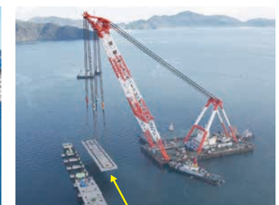
国内最大規模のPCa床板(長さ53.8~58.4m×幅11.5m)
