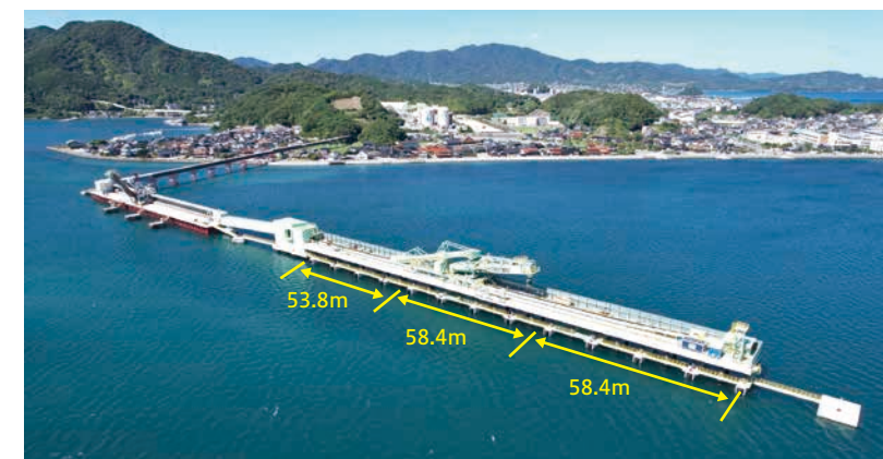
秋芳鉱山栈橋延伸工事
