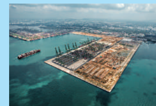
パシルパンジャン コンテナターミナル3・4期埋立 2007年 1期工事に続き受注した コンテナターミナル建設工事
