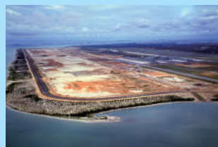
チャンギ国際空港用地埋立 1976年 当時東南アジア最大の埋立工事
