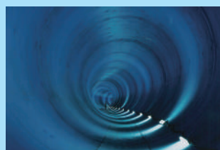
大深度下水道トンネル(DTSS) 1999年 海外で初めての 長距離シールド工事
