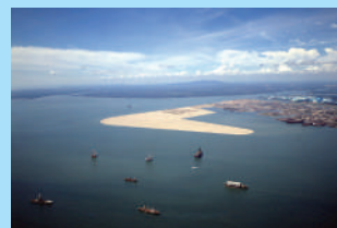
トゥアス埋立 1984年 約700億円の世界最大規模の 埋立工事
