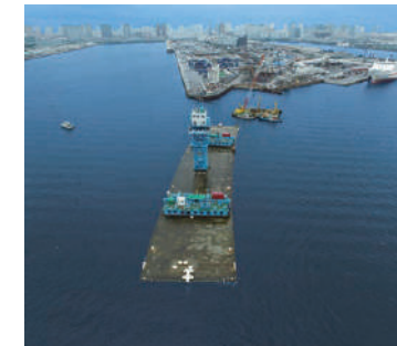
東京港 海の森トンネル
