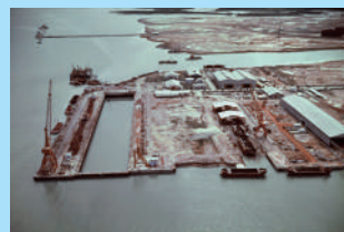
ジュロン造船所ドックおよび岸壁 1964年 シンガポールでの最初の プロジェクト
