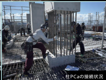
1階床でのサイトPCa施工状況
