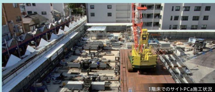
1階床でのサイトPCa施工状況
