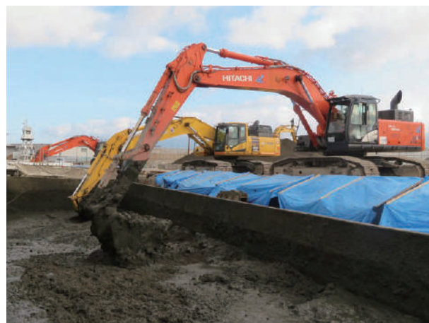
バックホウでの浚渫土とカルシア改質材の混合
