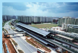
MRT ユーティー駅、克蘭ジ駅 1993年 シンガポールで受注した 初の鉄道工事
