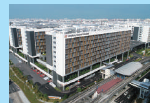
センカン総合病院 2014年 当社過去最大受注額の建築工事
