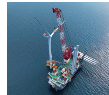
北九州響灘洋上風力発電事業風車基礎・海洋工事等
