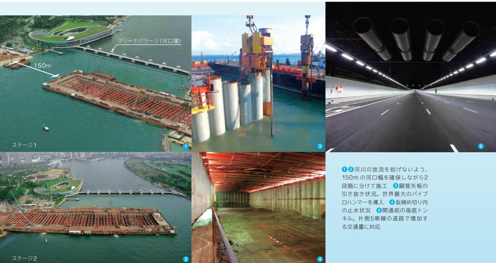
①② 河川の放流を妨げないよう、150mの河口幅を確保しながら2段階に分けて施工 ③ 鋼管矢板の引き抜き状況。世界最大のパイプロハンマーを導入 ④ 仮締め切り内の止水状況 ⑤ 開通前の海底トンネル。片側5車線の道路で増加する交通量に対応
