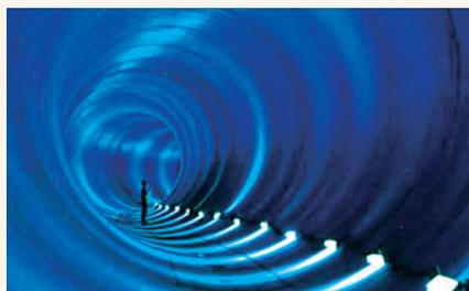
下水道トンネル整備事業として、地下35～45mの深さに、内径6m、延長7.7kmの巨大なトンネルを施工。一台の密閉型シールド(土圧式シールド)での掘削距離は、当時世界最長であった。
