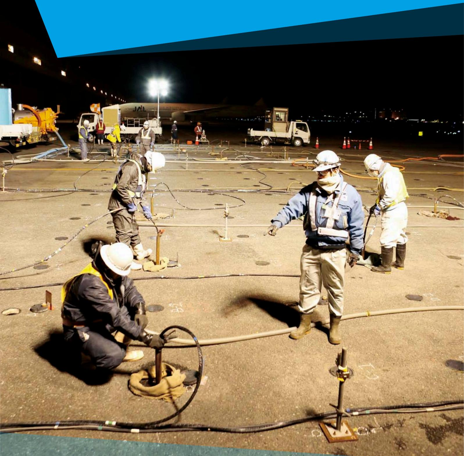
羽田空港では国の新成長戦略のもと、国際拠点となる24時間空港化を目指し、機能を拡張する整備が進められています。また、地震災害時においても輸送拠点空港としての機能を確保する必要があるため、耐震化工事も行われています。本工事では五洋建設が開発に携わった液状化対策技術による地盤改良工事を行い、耐震性の向上に寄与しました。
