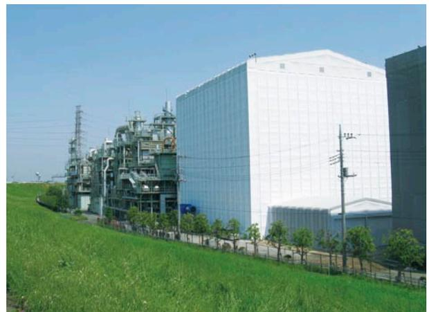
ダイオキシン漏出防止のため焼却炉全体を密閉養生
