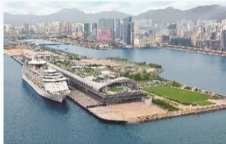
カイトッククルーズ ターミナル完成 (2013年)
