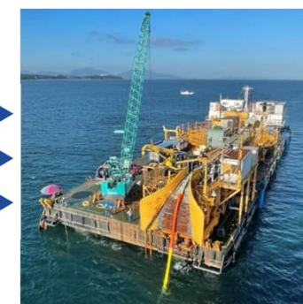
ケーブル敷設
