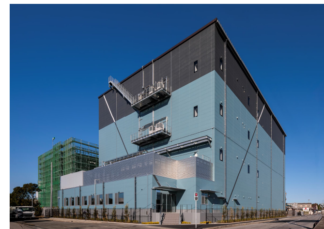
安田不動産(株) LOGION習志野 (千葉県 25年9月竣工)
