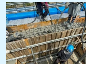
CELBIC-RAの打込み状況
