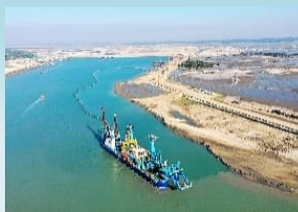
自航式ポンプ浚渫 船「カシオペアV」 完成 (2014年)
