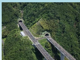
新東名高速道路 小河内トンネル完成 (2005年)
