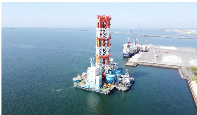
仙台塩釜港石巻港区雲雀野地区岸壁(-12m)(耐震)地盤改良工事 (宮城県 25年12月竣工)
