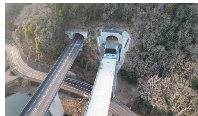
東海環状自動車道々々利第二トンネル他1トンネル工事 (岐阜県 25年4月竣工)
