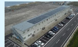
北九州響灘洋上風力建設 工事事務所
