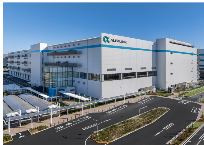
尼崎40ジスティック特定目的会社 ALFALINK尼崎 北棟 (兵庫県 25年10月竣工)
