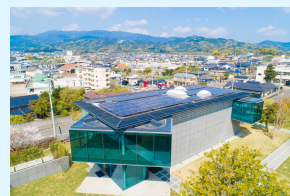
久光製薬ミュージアム 建設工事
