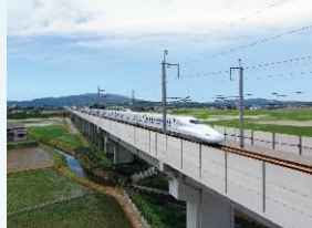
九州新幹線玉名 津留高架橋完成 (2008年)
