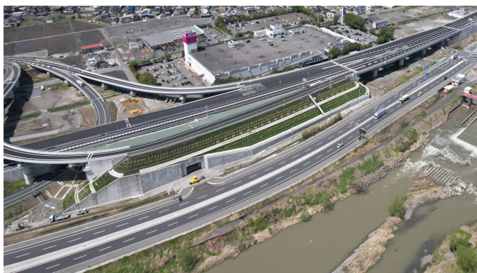
東海環状自動車道高柳工事 (三重県 25年5月竣工)
