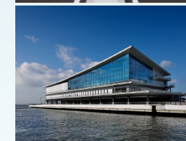
東京国際クルーズ ターミナル完成 (2020年)
