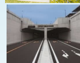
東京港海の森 トンネル完成 (2020年)
