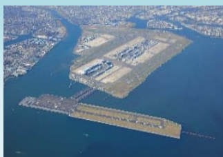
東京国際空港D 滑走路供用開始 (2010年)
