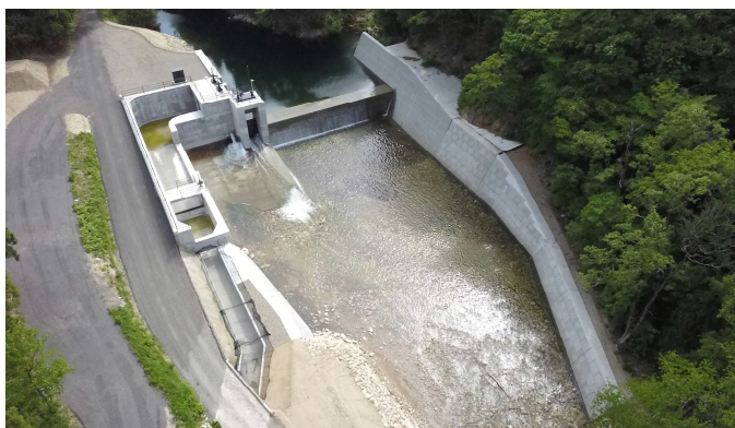
黒河川水力発電所新設工事 (福井県 25年5月竣工)
