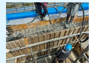
CELBIC-RAの打込み状況
