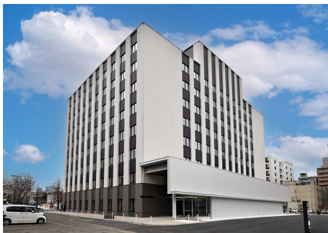
北海道開発局 札幌第4合同庁舎 (北海道 26年2月竣工)
