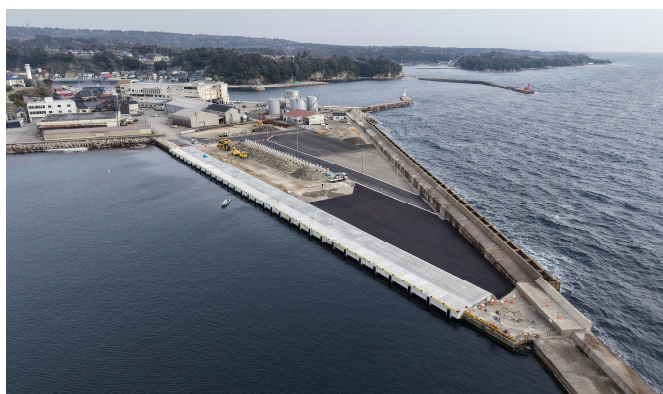
小木港 (小木地区) 岸壁 (- 4. 5 m) (災害復旧) 改良外 1 件工事 (石川県 26年3月竣工)
