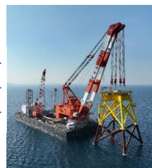
ジャケット据付
