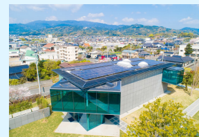
久光製薬ミュージアム 建設工事
