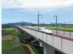
九州新幹線玉名 津留高架橋完成 (2008年)
