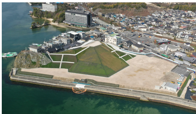
(仮称)宮島口西地区造成工事 (広島県 26年3月竣工)
