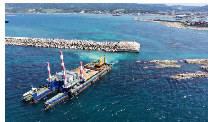
輪島港 (河井地区) 泊地 (- 7. 5 m) (災害復旧) 浚渫外 1 件工事 (石川県 26年3月竣工)
