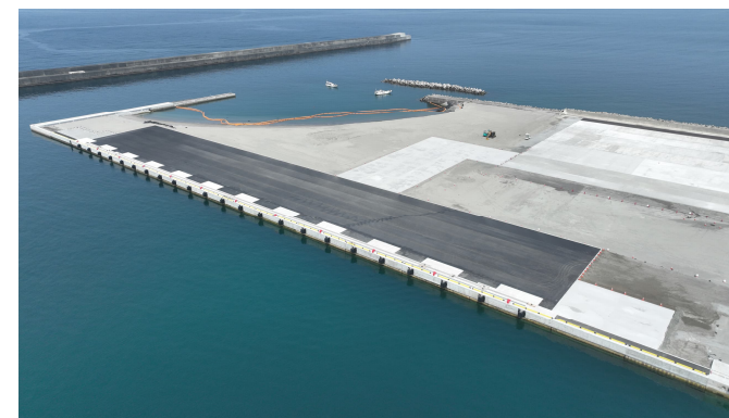
令和 7 年度川内港 (唐浜地区) 岸壁 (- 1 2 m) 築造工事 (鹿児島県 26年3月竣工)
