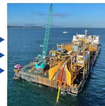
ケーブル敷設
