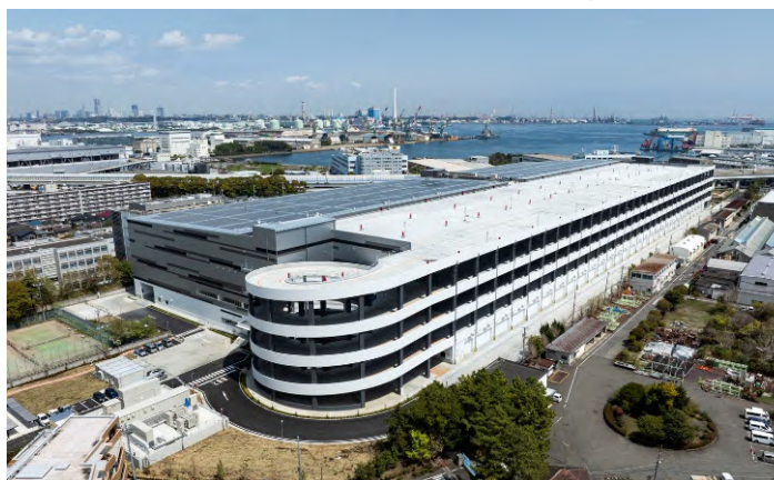
(仮称) Landport横浜新杉田新築工事 (神奈川県 25年3月竣工)
