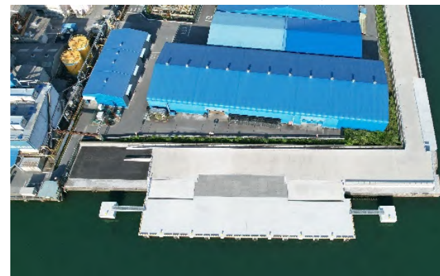
小野建株式会社 静岡センター棧橋新設工事 (静岡県 24年5月竣工)
