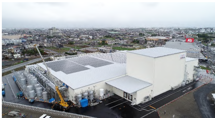
丸和油脂株式会社 羽生工場 (埼玉県 24年4月竣工)
