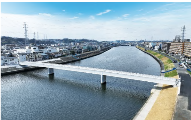
鶴見川人道橋 (神奈川県 25年3月竣工)
