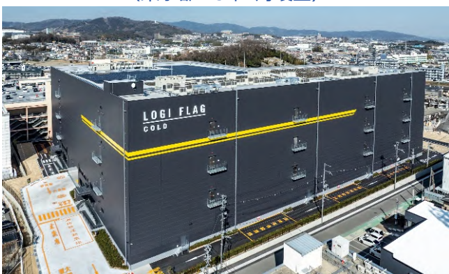
LOGI FLAG COLD 大阪茨木 I (大阪府 25年2月竣工)
