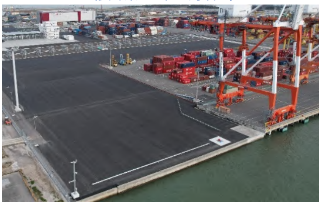
大阪港北港南地区荷さばき地(C12)整備工事 (大阪府 24年4月竣工)
