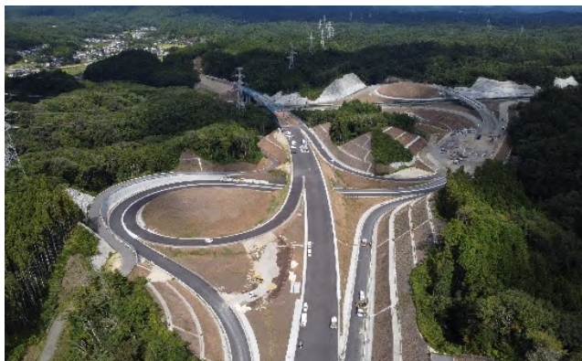
小名浜道路山田工事 (福島県 24年9月竣工)
