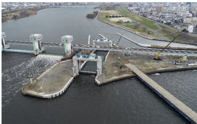
淀川大堰閘門閘室他整備工事 (大阪府 24年12月竣工)
