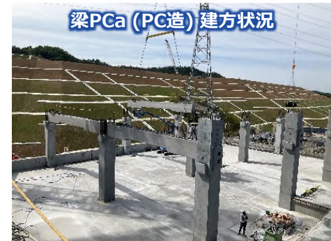
1階床梁PCa (PC造) 架設状況
