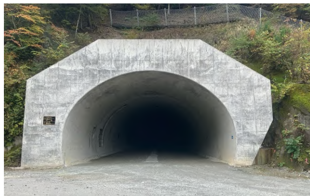
国道474号 三遠南信自動車道 青崩峠トンネル (長野県 24年12月竣工)
