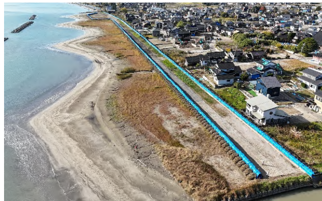
令和6年能登半島地震宝立正院海岸緊急復旧工事 (石川県 24年12月竣工)
