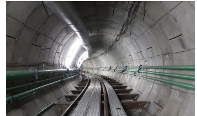
大田区仲池上二丁目、東雲谷四丁目付近枝線工事 (東京都 24年3月竣工)
