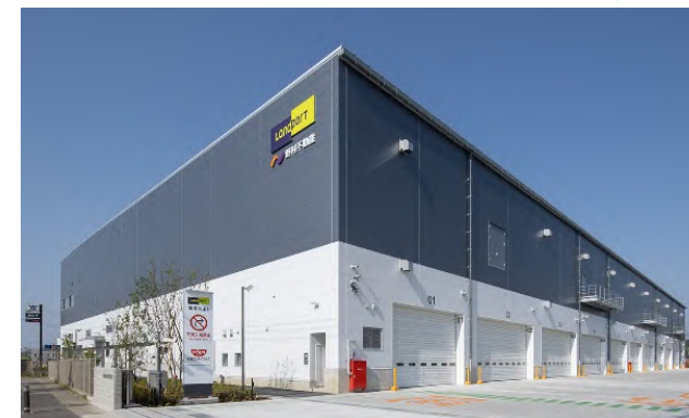
Landport福岡久山 I (福岡県 23年8月竣工)
