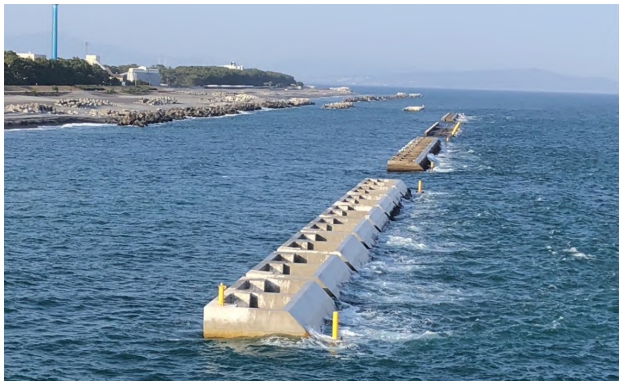
令和2年度駿河海岸藤守離岸堤工事 (静岡県 24年3月竣工)
