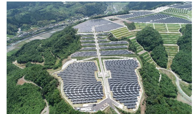
九州おひさま発電(株)人吉太陽光発電所造成工事 (熊本県 23年6月竣工)
