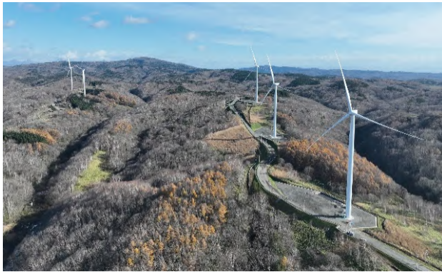
石狩八の沢ウインドファーム風力発電機据付他工事 (北海道 24年3月竣工)
