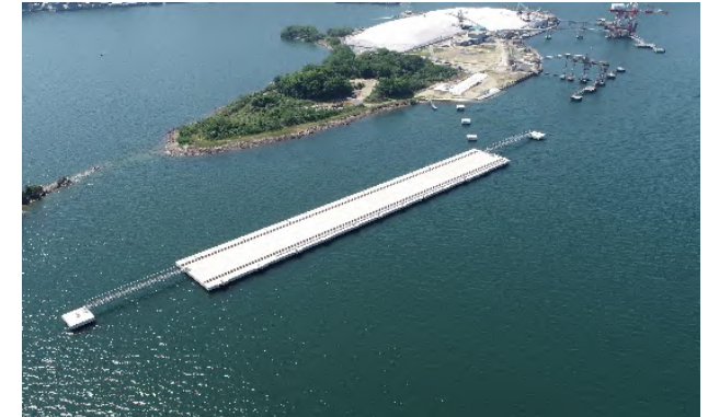
(仮称)第三栈橋新設工事 (広島県 23年8月竣工)
