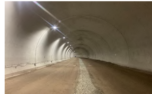
熊本57号笹原トンネル新設工事 (熊本県 23年7月竣工)
