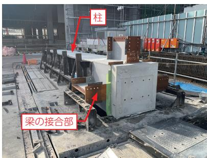
柱と梁の接合部を一体化したPCa部材
