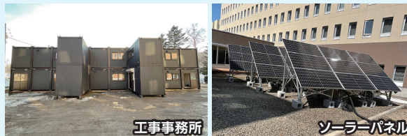
現場工事事務所のZEB化 (省エネ+創エネ)
