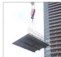
下がり壁の揚重状況
