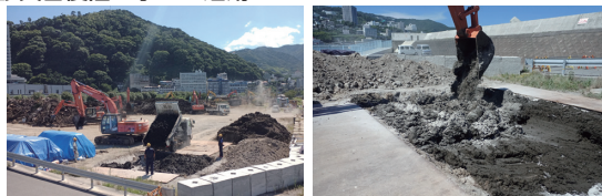
令和3年7月熱海伊豆山土砂災害復旧に「ワトル」を納入
