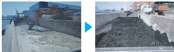
土運船内でのバックホウ混合の状況
