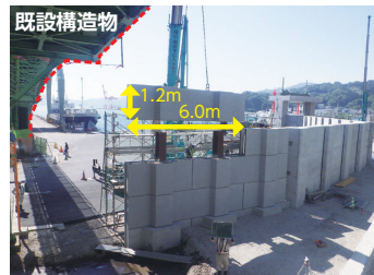
写真：同種工事の釜石港須賀地区海岸災害復旧工事より
