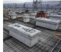
機械基礎の設置状況
