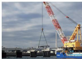
損傷PC桁撤去状況（CP-5001）
