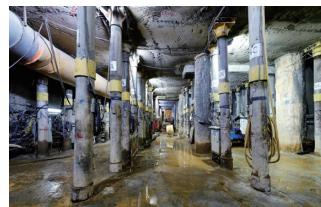
アンダーピニングエリア 掘削時の様子
