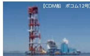
南側護岸地盤改良工事
