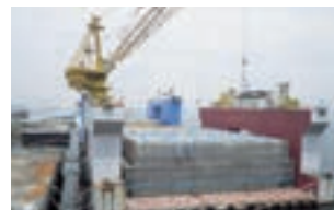
Dブロックケーソン製作工事
