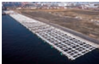
東京港中央防波堤外側地区岸壁 (-16m) 築造工事
