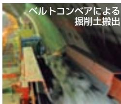
ベルトコンベアによる掘削土搬出
