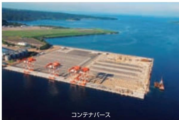
当社は、コンテナバース（2,000TEU、水深-13.7m、延長280m、2バース）、既設岸壁の拡幅・補修（3箇所）、アクセス道路（3km）、事務所棟のほか、ガントリークレーン（4基）、港湾サービス船舶（7隻）、船舶航行支援設備を建設・供給しました。
