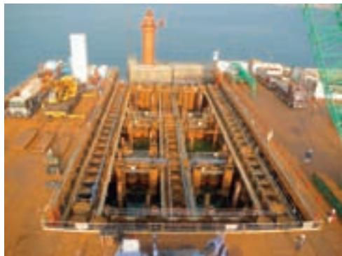
鋼管矢板井筒基礎(仮締切時)
