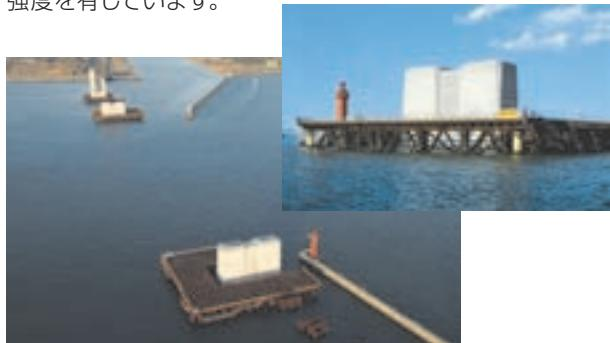
この橋脚がある東京湾の海底には、非常に柔らかい粘土が30m以上も厚く堆積しています。本工事では、鋼管矢板で作った仮設の締め切り壁を本体基礎と兼用する『鋼管矢板井筒基礎』が採用されました。これにより建設発生土を少なくして環境に配慮するとともに、工事費の縮減を図りました。また、さびないように表面にエポキシ樹脂を塗装した鉄筋を使用し、100年耐用を目指した高耐久性仕様の構造物となっています。
