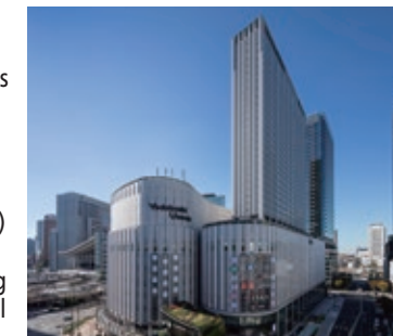
Yodobashi Umeda Tower
