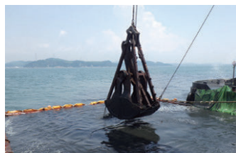
浅場・干潟造成状況(カルシウム改質土の投入)
