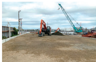
干潟表土の仮置き状況
