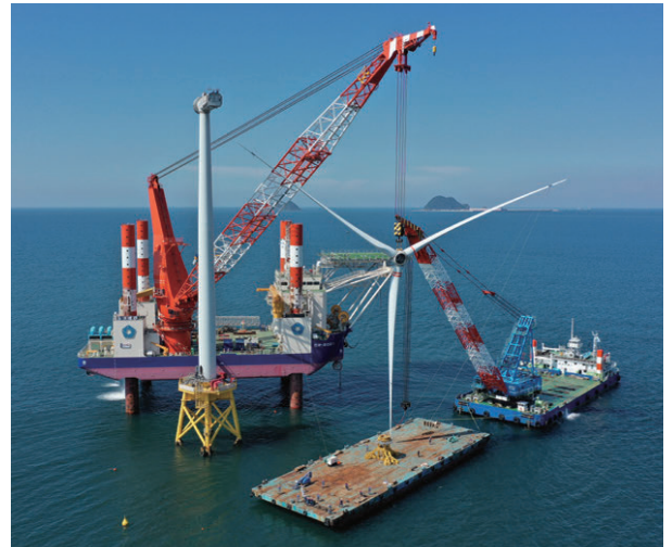
北九州沖洋上風力撤去(風車輿の船船がCP-8001)
