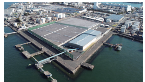
名古屋土壤再利用センター
