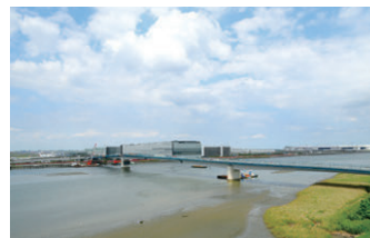
橋梁設置・干潟表土復元後の状況
