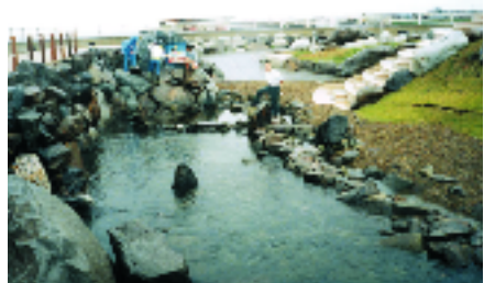
人工磯場(当社施工)
