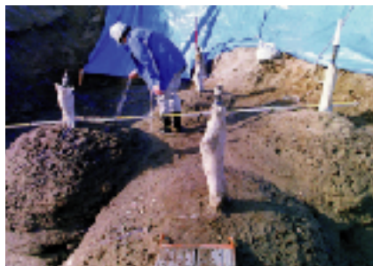
改良状況(現場実証実験)
