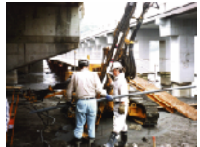
注入管の建て込み
