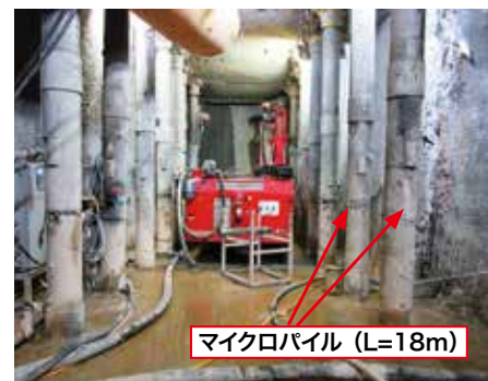
マイクロパイルの打設状況。中ほどに見える連結器で上下2本の鋼管をつなげている
