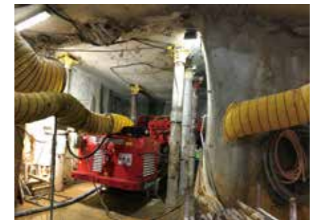
既設駅舎の下を掘り進める前に実施した水平方向の地盤改良の様子
