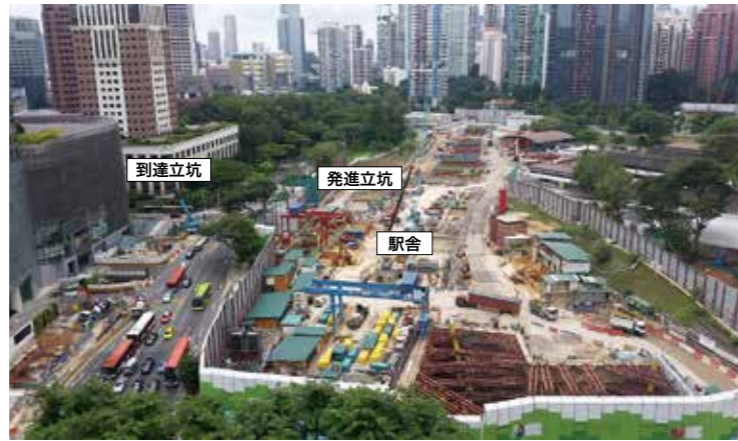
2017年11月の現場。パイプルーフの立坑が道路を挟んで位置する。駅舎と退避所が広い範囲で施工中
