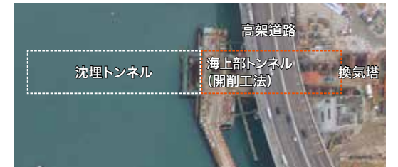
九龍側取付部。写真で示したように、現場の上を横切る高架道路下に仮設構台を構築し、開削工法の締切構造で施工した
