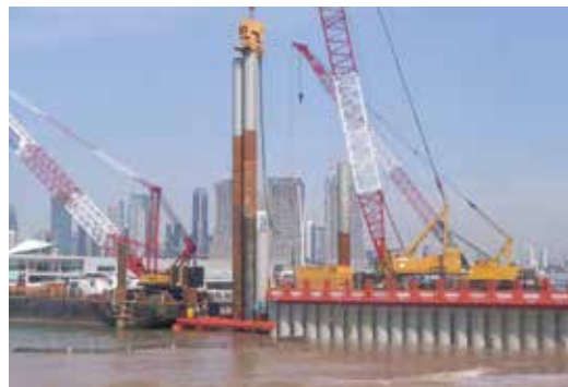
道路の線形に沿って鋼管矢板を2重に打設し、その上に構台を築く。鋼管矢板の内側には土砂を投入し、陸化していく
