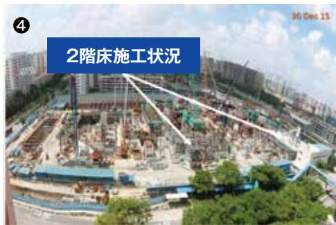
この現場では順打ち工法と逆打ち工法を組み合わせたセミトップダウン工法を採用した。①は、「逆打ち」の部分で地上1階床を構築しているところ。②は、「順打ち」の部分で周囲を地上1階床に囲まれた仮設開口部を掘削しているところ。③では、同じく仮設開口部で掘削を終え、地下2階床を構築している。④では、「逆打ち」の部分で地上2階床を構築している
