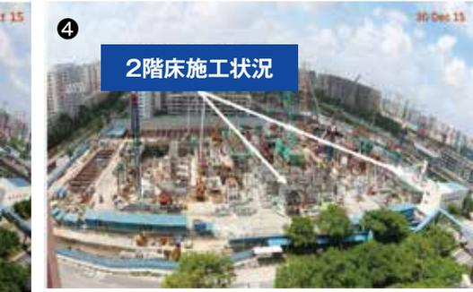
この現場では順打ち工法と逆打ち工法を組み合わせたセミトップダウン工法を採用した。①は、「逆打ち」の部分で地上1階床を構築しているところ。②は、「順打ち」の部分で周囲を地上1階床に囲まれた仮設開口部を掘削しているところ。③では、同じく仮設開口部で掘削を終え、地下2階床を構築している。④では、「逆打ち」の部分で地上2階床を構築している
