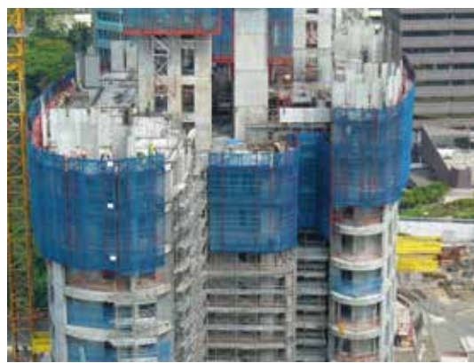
富裕層向けレジデンスを構成するプレキャストコンクリート造の躯体。青いネットに覆われている部分は、墜落や落下物を防ぐ目的で利用するセルフ上昇式の足場
