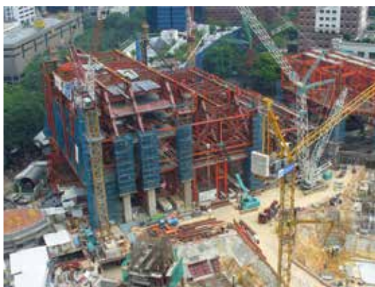
地上8階までの鉄骨造の躯体。商業施設と駐車場から構成される。左側半分は、すでに「メガトラス」が所定の高さまで引き上げられている
