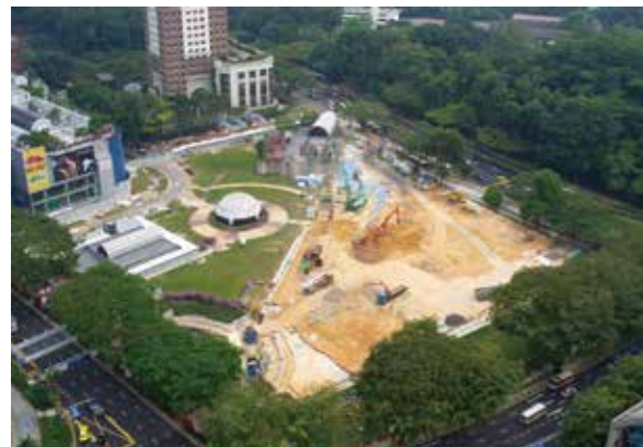
着工間もなくの敷地。もともとは公園として暫定利用されていた。左手に見えるのが、目抜き通りのオーチャードロード。写真下から上に敷地を斜めに横断する形で「MRT」と呼ばれる地下鉄の駅舎が地下にある
