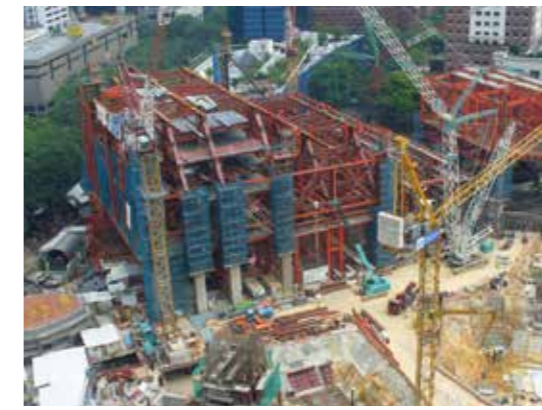
地上8階までの鉄骨造の躯体。商業施設と駐車場から構成される。左側半分は、すでに「メガトラス」が所定の高さまで引き上げられている
