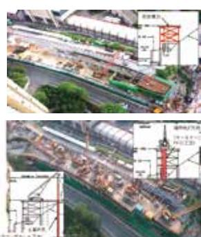
上図2点は、開削工法で施工するトンネルの平面と断面。土留め用の鋼管杭やトンネルの躯体を支える場所打ち杭を打設し、斜面上を掘削・開削したうえで、トンネルの躯体工事を施す必要がある。左の写真2点のうち上は、仮設備台を構築しているところ、下は2種類の杭を打設しているところ。杭の打設はヒンキン駅舎に近い側から一定の区域ごとに進めた。区域ごとに杭を打設し終えると、構台の一部を解体し、掘削を進める、という手順を、施工区間約134mを13区間に分けて繰り返した。仮設備台を段階的に解体するときには、そのたびに構台の安全性と安定性を保つことが求められた。
