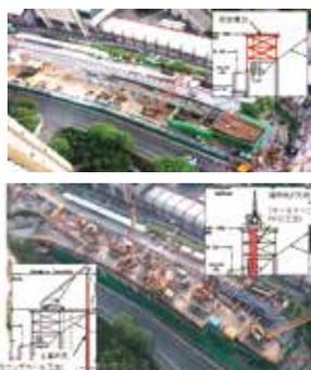
上図2点は、開削工法で施工するトンネルの平面と断面。土留め用の鋼管杭やトンネルの躯体を支える場所打ち杭を打設し、斜面上を掘削・開削したうえで、トンネルの躯体工事を施す必要がある。左の写真2点のうち上は、仮設構台を構築しているところ、下は2種類の杭を打設しているところ。杭の打設はヒンキン駅舎に近い側から一定の区域ごとに進めた。区域ごとに杭を打設し終わると、構台の一部を解体し、掘削を進める、という手順を、施工区間約134mを13区間に分けて繰り返した。仮設構台を段階的に解体するときには、そのたびに構台の安全性と安定性を保つことが求められた。
