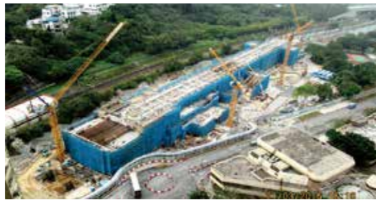
2015年3月段階。現場ではタワークレーン4基を利用。ブームが既設路線の軌道上に侵入しないように、旋回範囲を限定するとともに、ブームの侵入をセンサーで検知する仕組みを取り入れた
