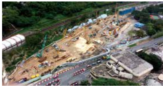
ヒンキン駅舎の建設工事。2014年5月の段階。緑に覆われた斜面の上にMTRの既設路線の軌道が見える。高架橋建設工事の作業エリア拡充のため、ロータリーは左手前に移設した
