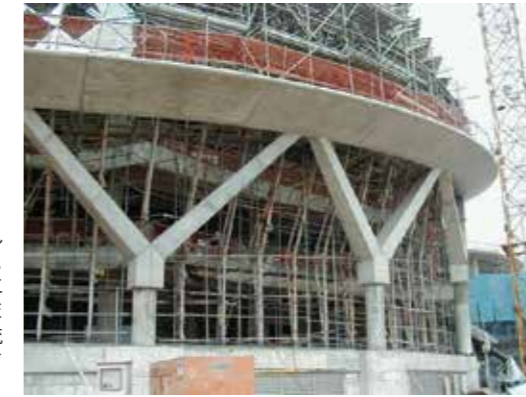
「Lower Gutter」とそれを支えるV字型の柱。「Lower Gutter」は工場生産のPC製パネルだが、V字型の柱は高流動コンクリートを用いて現場で打設した
