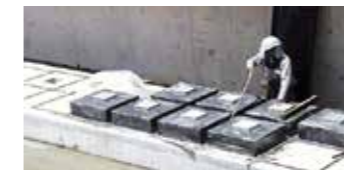
防振ゴムの設置風景。基礎の上に並べる。静寂躯体の施工時には防振ゴムの変位を随時計測し、それが許容範囲に収まることを確認しながら作業を進めた。壁側は建物の構造体との間に50mmの空間を確保し、固定伝播音を遮断している
