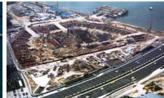
地下2期工事の掘削区域は半円に近い形状で、面積は1万7400㎡にも及んだ
