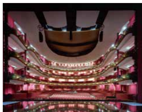
左：コンサートホール内部。ステージの真上、天井に設置されている装置が、可動式音響反射板。これを昇降させることで、演奏者に最適な音を確認してもらう 右：劇場内部。馬蹄形の客席をステージから望む。天井や壁では比重の大きいGRG（ガラス繊維強化石膏）パネルを躯体に密着させ、音を反射させる一方で、表面には下地との間に空気層を挟むようにタイシルクを張り、高周波音を吸収させる
