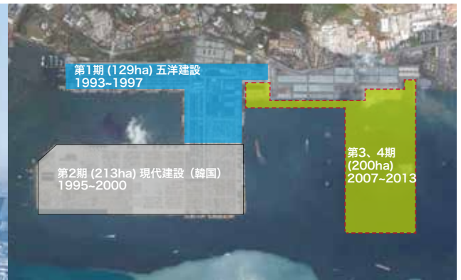
パシルパンジャン地区でのコンテナターミナル建設は4期にわたって進められ、3・4期の完成によって、年間5000万TEUのコンテナ取扱量が可能となる
