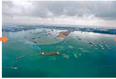
②2010年4月 仮築堤の西側から埋立開始。硬質粘土層の軟弱化で工事に手戻りが発生し、ケーソンを仮置きする光景も見られる
