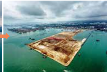
③2011年12月 中央の仮築堤で仕切られた先行引き渡しエリア(左手奥)の埋立が完了
