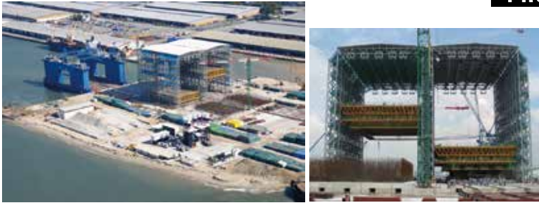
左の写真はケーソン製作ヤードの全景。正面の「ガントリースリップフォーム」でケーソン2函を同時に製作する。コンクリートの打設完了までは約1週間。打設後はケーソンを作業船まで移動させ、現場まで曳航する。右の写真がガントリースリップフォームシステム。コンクリートを打設する作業エリアを上昇させながら、下からケーソン函体を立ち上げていく
