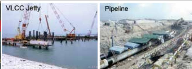
左はVLCC(大型原油タンカー)棧橋の建設風景、右はパイプラインの埋設風景。パイプラインは、VLCC 棧橋とジュロン地区内の既設製油所との間を結ぶ
