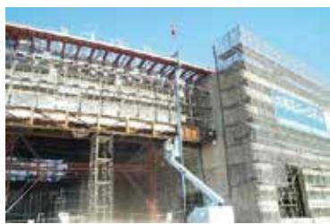
ガラスカーテンウォールの施工における方立の吊り込み作業。庇鉄骨の下に方立を吊り下げるため、作業時にはその鉄骨が「魔になる」。そこで施工を担当したJVでは専用の治具を開発・製作し、庇鉄骨をかわしながら方立を吊り込めるように工夫した
