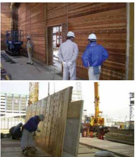
建物の内外壁は、大部分がレンガとコンクリート打ち放し仕上げだ。壁の表面には杉板の木目をつけることになっていたため、型枠の内部に杉板を張り、コンクリートを流し込んだ。最も大きな壁面は高さが6mあり、一気にコンクリートを流し込むと型枠が破損しかねない。しかも壁の長さは20m。複数の工区に分けたうえで、工区ごとに打設していかなければならないが、時間をかけすぎると打ち継ぎの部分にラインを残したり、空隙が残るような打設不良が生じたりしてしまい、せっかくの杉板の木目の美しさが損なわれてしまう。そこで重要なのが打設時間の管理だ。打ち放し以外の打設箇所で実際に計測を行い、時間内で打設が完了するように徹底的に管理した。
