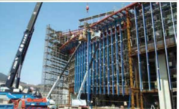
建物の南西面はガラスのカーテンウォールで構成されている(写真上)。内部に展示される戦艦「大和」の模型の背景として目立たないように、また外部からも模型を眺められるように、ガラスを両脇から挟み込む方立には見付け幅の細さが要求されていた。設計者、施工者、サッシメーカー、ガラスメーカーの4者でプロジェクトチームを組み、カーテンウォールの詳細設計を固める中で、方立やガラスには吊り構造を採用することや方立の見付け幅は60mmに抑えることなどを決定した。写真下は、方立の吊り込み作業の様子。関係者がチームを組み、6ヶ月にわたりて詳細設計の検討を重ねたことで、設計者の意図をくみ取り、さらに地震時や強風時には方立やガラスが変位に追従し、安全を確保できるカーテンウォールを完成させることができた。
