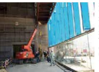
カーテンウォールの下部もガラス面で構成する。下部で最大のガラスは左の写真のように、中央部分にあたる上部のガラスを1枚取り外した状態で、上部のガラス同様、専用治具を用いて吊り込んだ。そのほかのガラスは右の写真のように、建物の内部から小型クレーンと人力で建て込んだ
