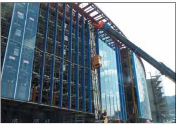
ガラスの吊り込み作業時にその鉄骨が「魔になる」という点は方立と共通だ。ガラスの吊り込み作業用にも専用の治具を開発・製作。ガラス面の中ほど的位置で吸着・固定し、ガラスを回転させて庇鉄骨をかわしながら、その下に吊り込めるようにしている
