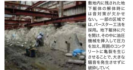
敷地内に残された地下躯体の解体時には音対策が欠かせない。一部の区域では、バースター工法を採用。地下躯体に穴を開け、その中に油圧機械を挿入して圧力を加え、周囲のコンクリートに亀裂を生じさせることで、大きな騒音を発生させずに破碎していく
