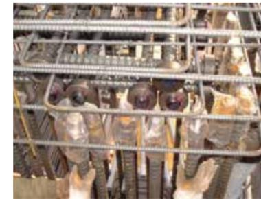
柱と梁の接合部内では主筋の定着が課題になる。図の左側に示したように、在来工法では鉄筋の端部を90度に折り曲げることで定着を図るが、こうすると鉄筋の過密度が増す。この現場では、納まりをミリ単位で調整しなければならぬほど過密に鉄筋が配置されていたため、在来の定着方法はとも採用できない。そこで、奥村組、鉄建建設、合同製鐵の3社と共同で開発した「EG定着板工法」(図の右側)を採用した。この工法は鉄筋端部に工場でネジを摩擦圧接し、現場ではそのネジにEG定着板を手で締め込むだけ。写真のように、鉄筋をすっきり納めることができる
