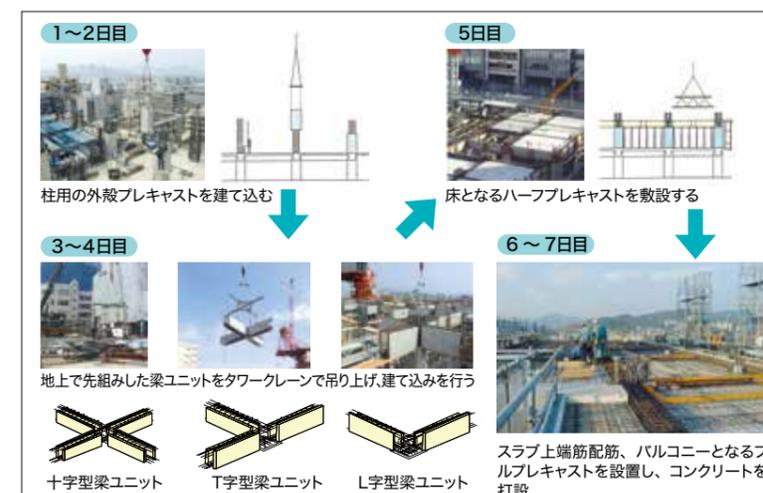
在来工法とフルPCa工法の間位置付けられる工法。PCa化を図るのは外殻のみ。柱は四周をPCa化し、せん断補強筋を組み込んでおく。それを主筋の位置に建て込み、内部は現場でコンクリートを打設する。梁は側面のみをPCa化。せん断補強筋も組み込んでおく。底面に型枠を組み込んだものを、十字型、T字型、L字型にユニットとして地組し、それを所定の位置に建て込み、内部は現場でコンクリートを打設する。フルPCa工法に比べ部材を軽量化できる一方、在来工法に比べ現場での配筋作業を省力化できる。写真は、現場での施工手順。ワンフロアを7日ペースで進めた。
