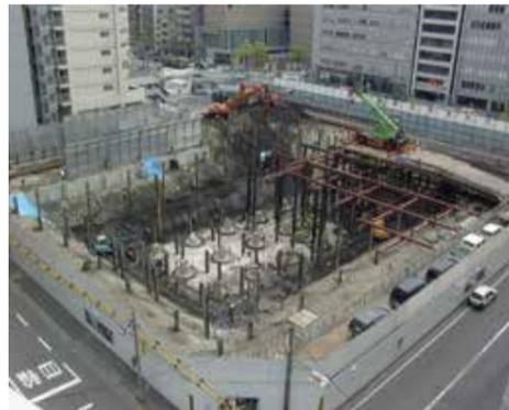
被圧地下水の水位が高いため、掘削だけを先行させると、地盤内の土圧と水圧のバランスが崩れてしまう。そこで敷地の中央部は躯体工事を先行させ、その重みでバランスの確保を図った。中国支店の土木部門との連携の中で生まれた工程の組み方である
