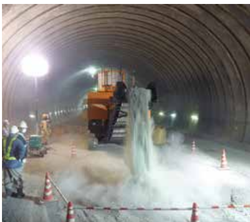
特定有害物質溶出対策の一つとして採用された不溶化工法の様子。右2点：可燃性ガス対策の換気設備と坑内に設置されたガス検知システムのモニター
