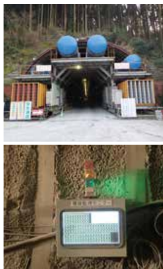
特定有害物質溶出対策の一つとして採用された不溶化工法の様子。右2点：可燃性ガス対策の換気設備と坑内に設置されたガス検知システムのモニター
