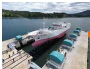
船舶を棧橋の間に引き込み、プラットフォームごと船舶を上架
