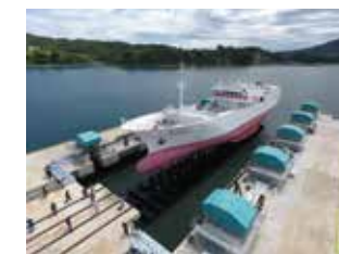
船舶を棧橋の間に引き込み、プラットフォームごと船舶を上架
