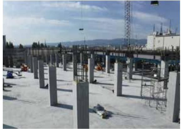
RC造の柱は現場で打設した。左の写真のように、現場ではコンクリートの打設に必要な足場を組まずに、コンクリートディストリビューター（コンクリート圧送用ブーム）を用いた。それによって、施工効率や安全性の向上を図り、材料ロスの低減をもたらすことができた。右写真は、打設後の様子。ここから、P-RCS構法によってS造の梁を架けていく
