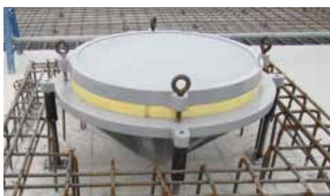
右の図に示したように、通常の在来免震では杭の上 まず地中梁を含む基礎を構築し、そこと躯体との間に免震装置を設置する。これに対して「BSL(回転機構付き滑り支承)」を用いた杭頭免震(BSL免震)ではその基礎部分を省き、杭頭と躯体との間に免震装置を設置する。これによって、基礎工事とその部分の掘削工事が不要になるため、コスト削減効果が得られる。物流施設は一般に床面積が広く、工事費全体に対する基礎工事や掘削工事の割合が大きいので、削減効果も大きい。写真はBSL。左の図には、その原理を示した。BSLを用いた杭頭免震では地震のときでも杭には鉛直荷重しか働かないため、杭の仕様を見直すことでさらにコスト削減を図れる。
